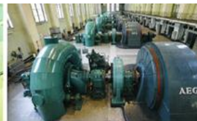
3 Turbinen und Generatoren in einem Wasserkraftwerk
